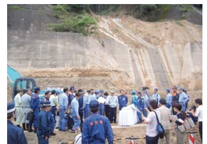
高速道路土砂崩れ現場の視察
