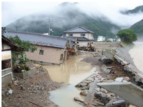
住家の被害状況 (兵庫県佐用町)
